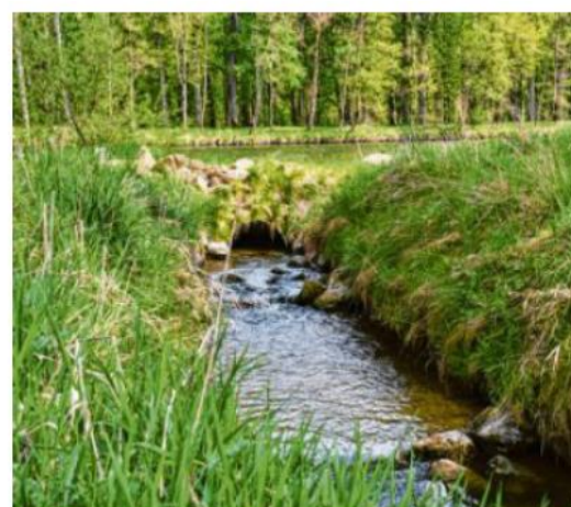
Kleine Maßnahme mit großer Wirkung: Dieses Rohr leitet frisches Donauwasser in einen Entwässerungsgraben.
