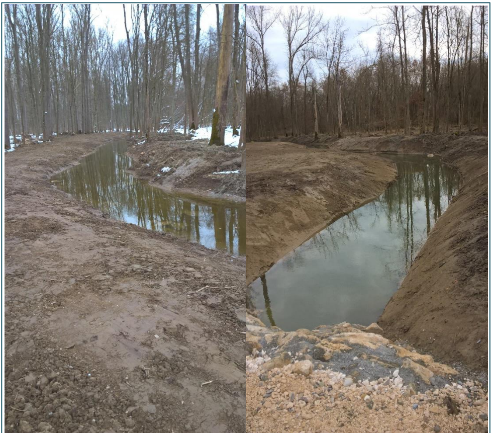
Abb. 7: Zulaufgraben unmittelbar nach Fertigstellung
