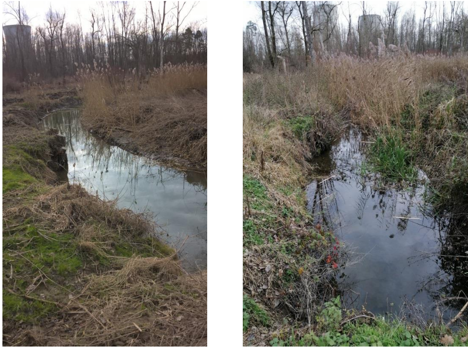
Abb. 22: Sanierte Anbindung des Altwassers „Nasenhaken“ nach der Sanierung im März 2018 (links) sowie im September 2019 (rechts). Die Fotos zeigen denselben Gewässerbereich.
