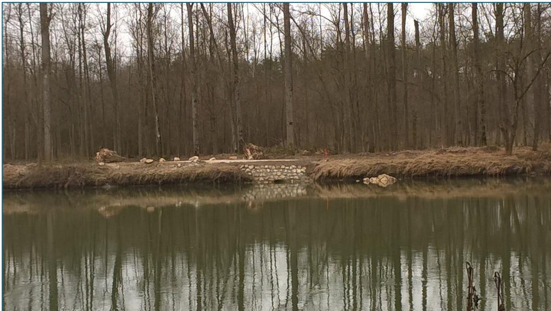
Abb. 5: Rohranbindung bei Donau-Fluss-km 2550 (re) mit vorgelagerter Störsteinstruktur (nach Fertigstellung)
