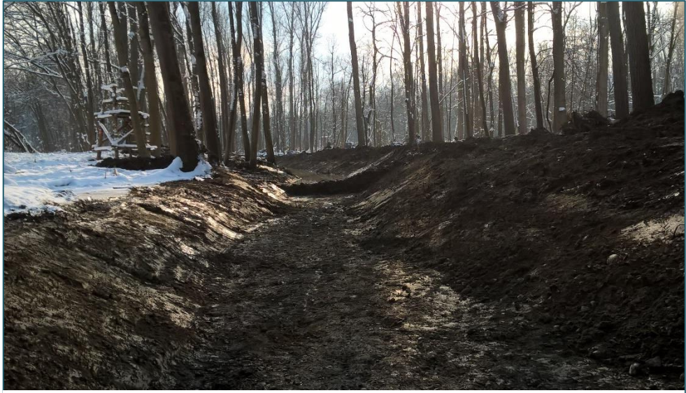
Abb. 6: Zulaufgraben während der Errichtung
